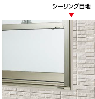
シーリング目地
