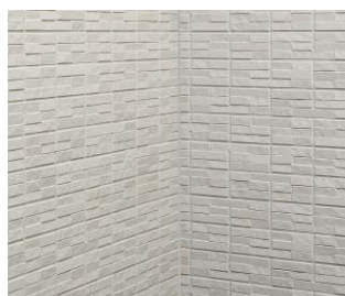
シーリング目地
