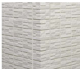
シーリング目地
